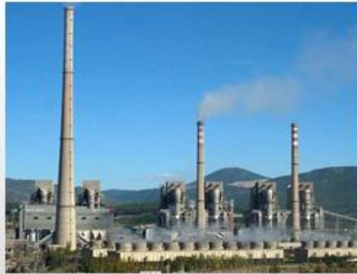
Yakıcının Isıl kapasite 21 MWth
