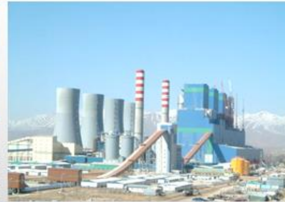
Yakıcının Isıl kapasite 46 MWth
