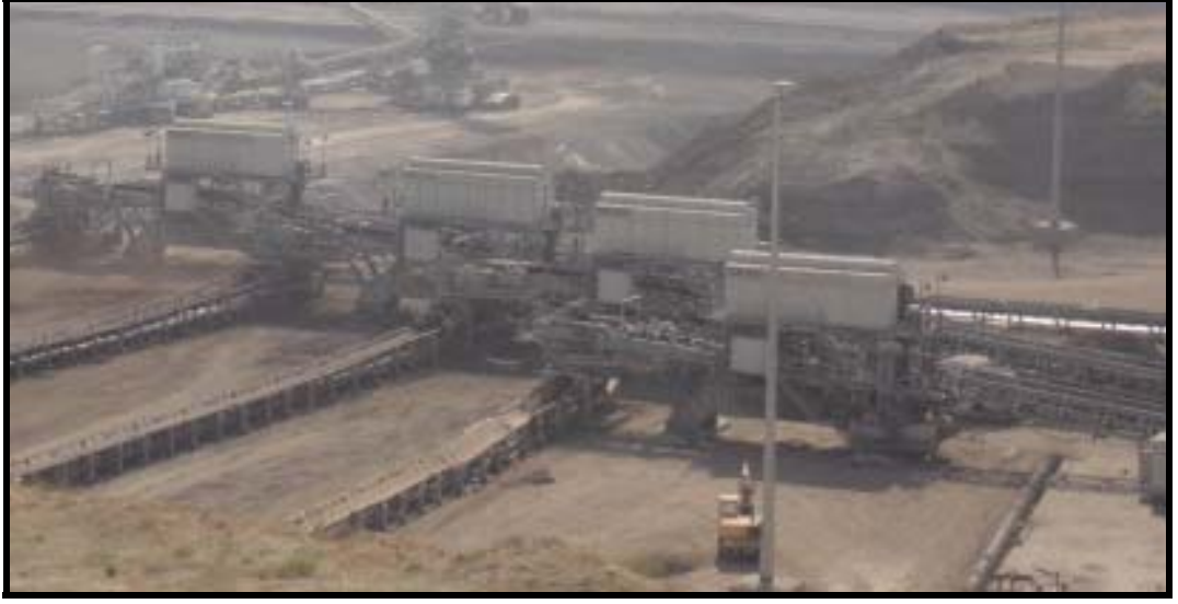
Şekil 3.3. Tahrik İstasyonlarının Görünümü
