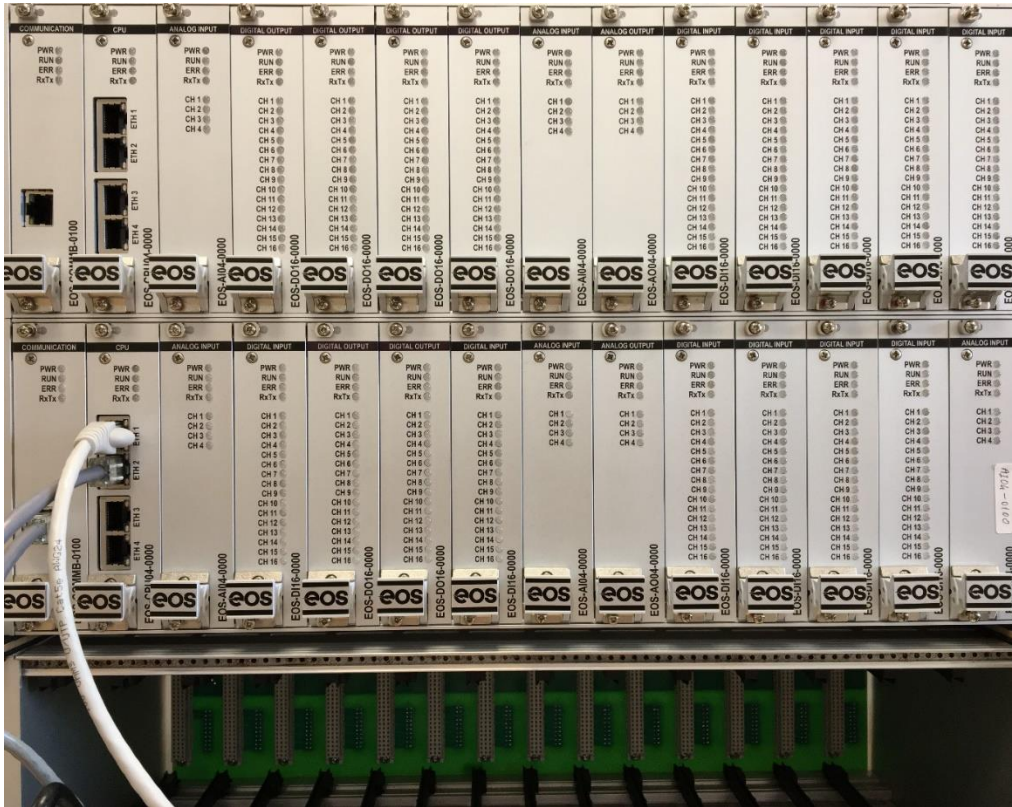
Şekil 3. EOS Subrack Yapısı
